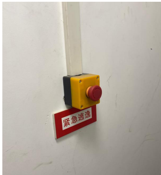
图 3-6 紧急止动装置
