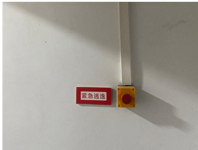
曝光室紧急逃逸开关及中文标识
