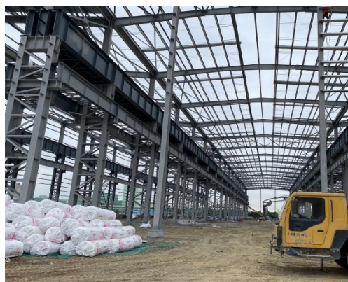
厂房建设情况
